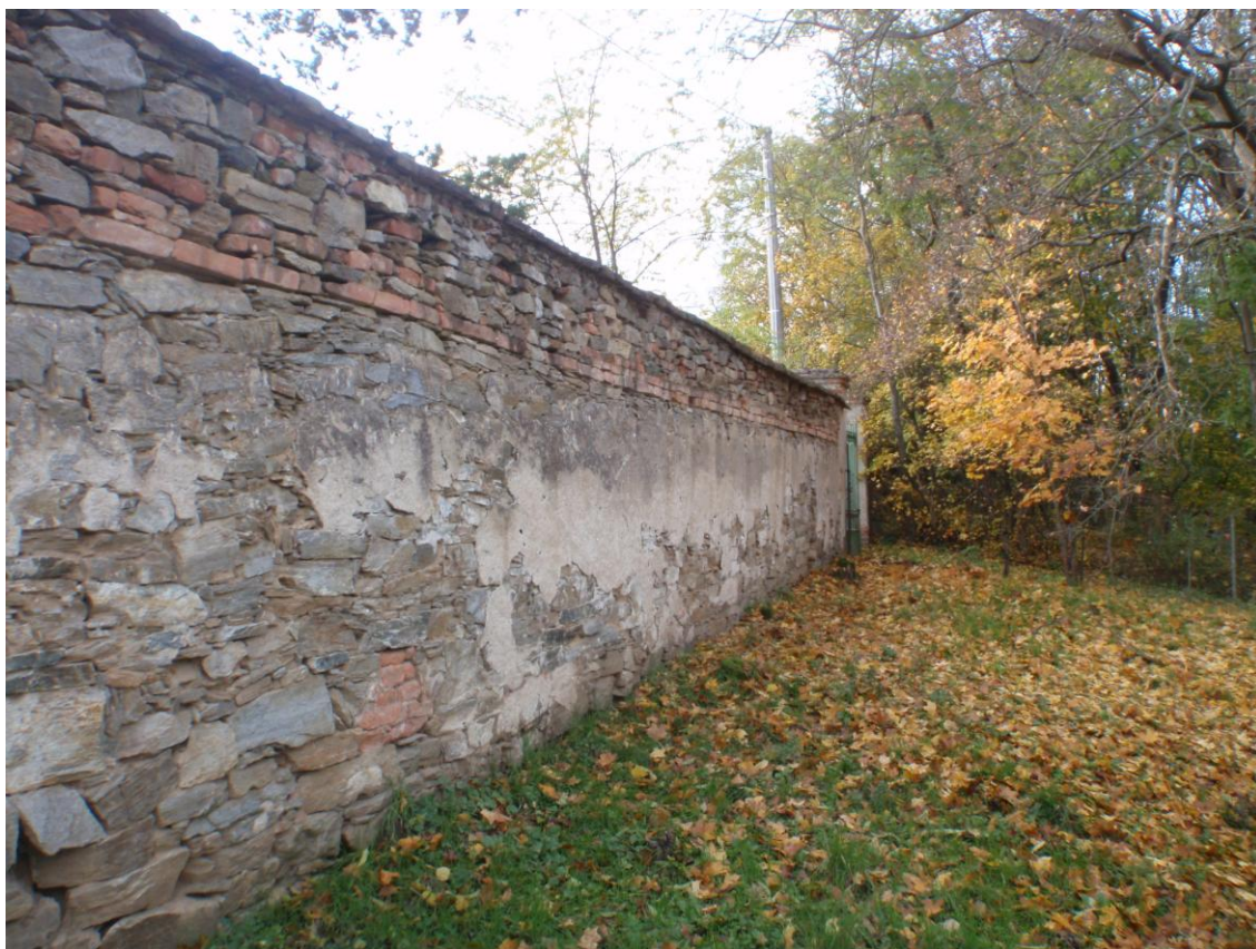
Ohradní stěna, jako celek, se nachází ve špatném stavebně technickém a lokálně nevyhovujícím statickém stavu. V krátkodobém horizontu je nutno přistoupit k sanačním opravám opěrné stěny v celém jejím úseku.
