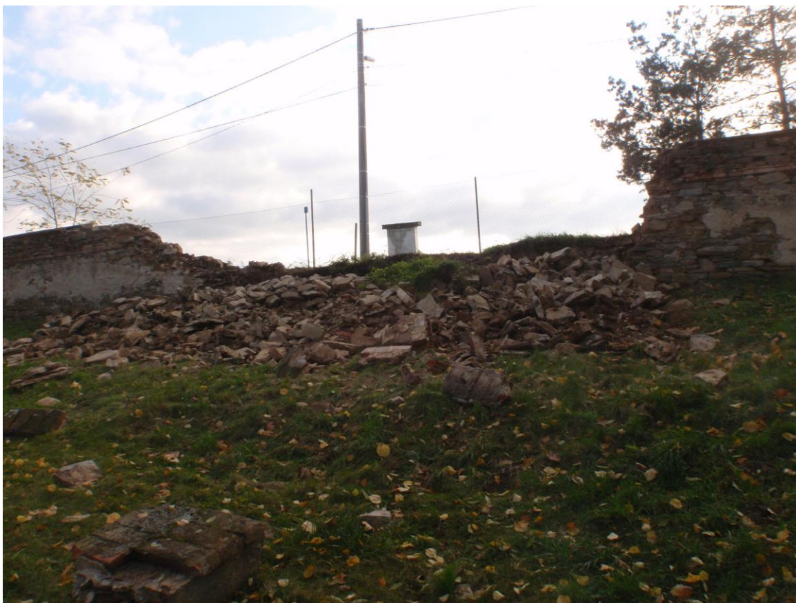
Pohled na řešenou havarovanou část ohradní stěny.
