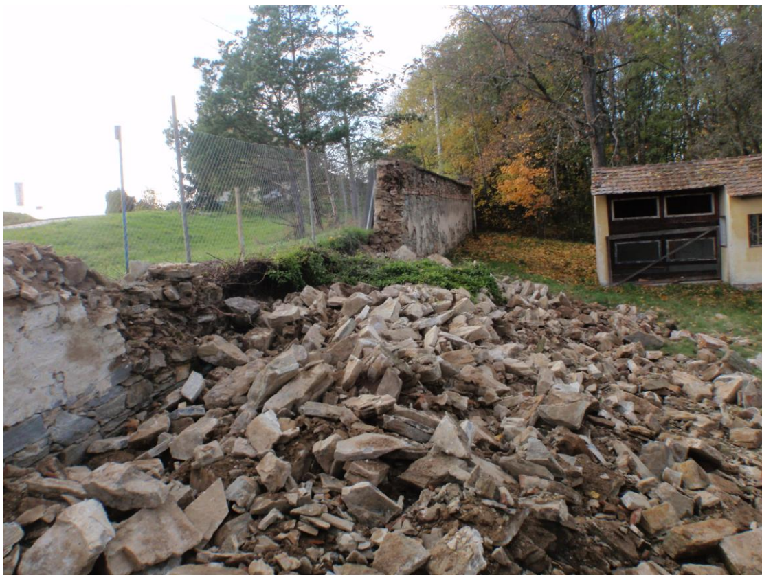
Stěna je tvořena lomovým kamenem, maximální výška dosahuje 2,80 m.
