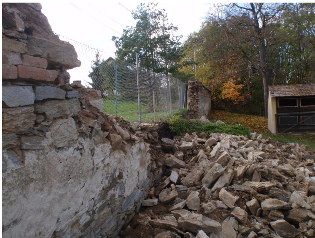
Obnova havarovaného úseku bude provedena z materiálu nalezeného v závalu pod zdí.
