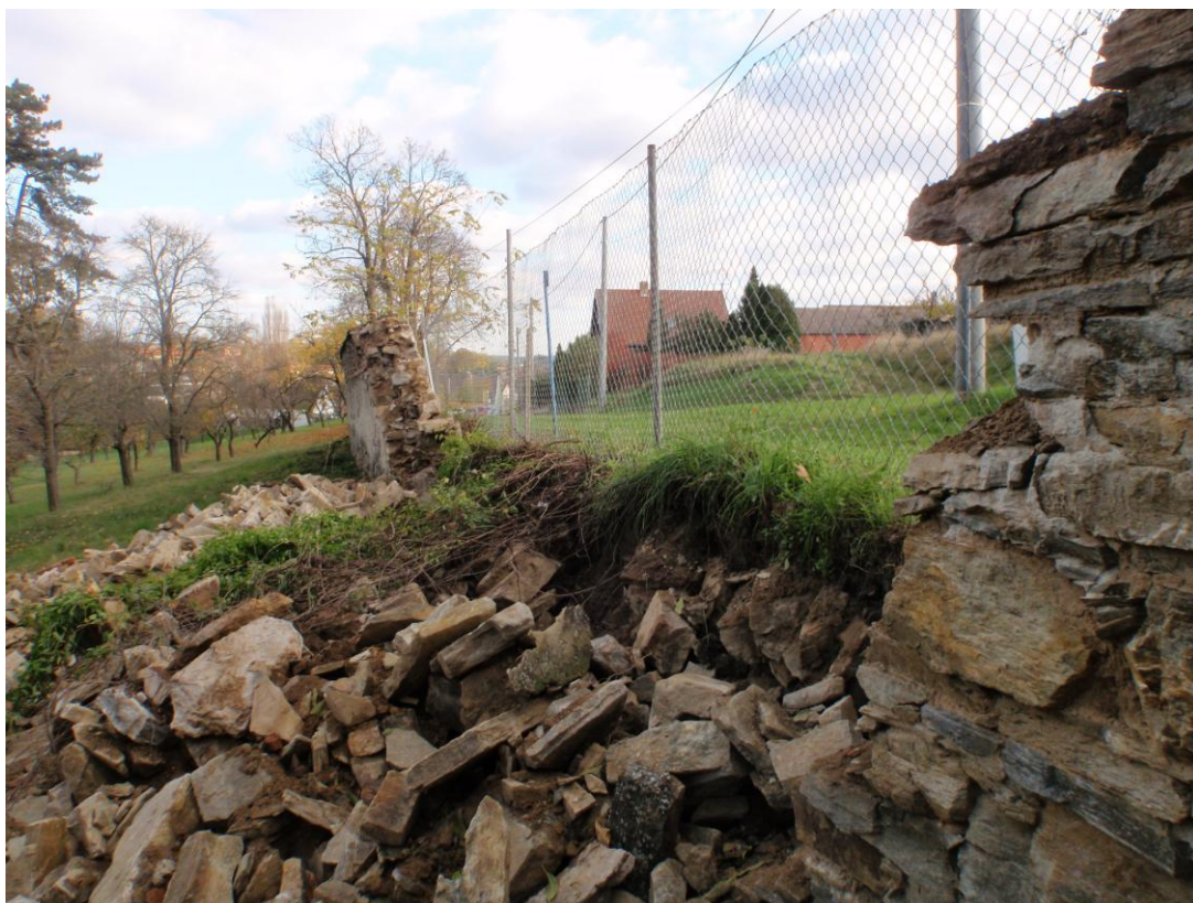
Součástí obnovovaného úseku budou skryté ž.b. ztužující pilíře, které zajistí stabilitu přilehlých vybočujících částí ohradní stěny.
